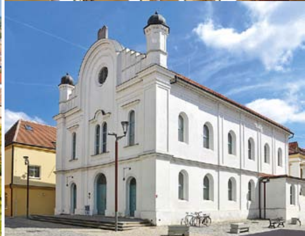
Interiér a exteriér synagogy, foto: archiv města
